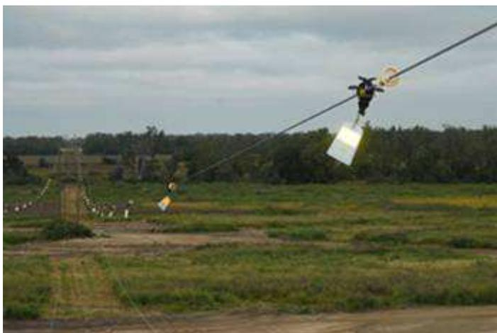
Рисунок 7.7. Сигналы (маркеры) на проводах могут уменьшить столкновения птиц с ними до 90% (источник: Altalink).
