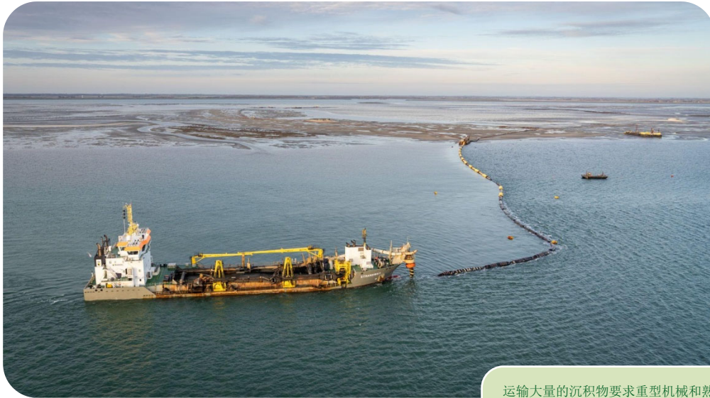
运输大量的沉积物要求重型机械和熟练的工人。这里沉积物被运送到船上，通过管道把沉积物用泵输送到目标区域。位置：荷兰东斯海尔德罗根帕拉特岛。[摄影: Edwin Paree]
