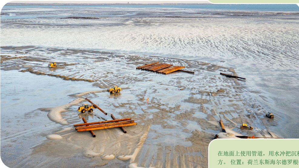
运输大量的沉积物要求重型机械和熟练的工人。这里沉积物被运送到船上，通过管道把沉积物用泵输送到目标区域。位置：荷兰东斯海尔德罗根帕拉特岛。[摄影: Edwin Paree]
