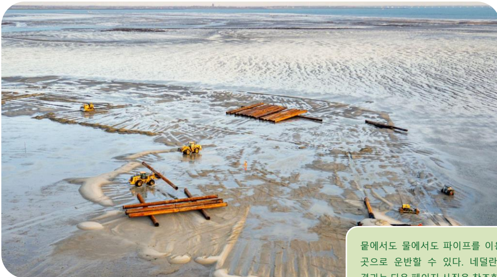
대량의 퇴적물을 옮기려면 중장비와 숙련된 노동력이 필요하다. 여기서 퇴적물은 배로 운반되어 파이프라인을 타고 목표 지점으로 이동한다. 위치: 네덜란드 우스터스켈트 로르헨플랏 [제공: Edwin Paree]
